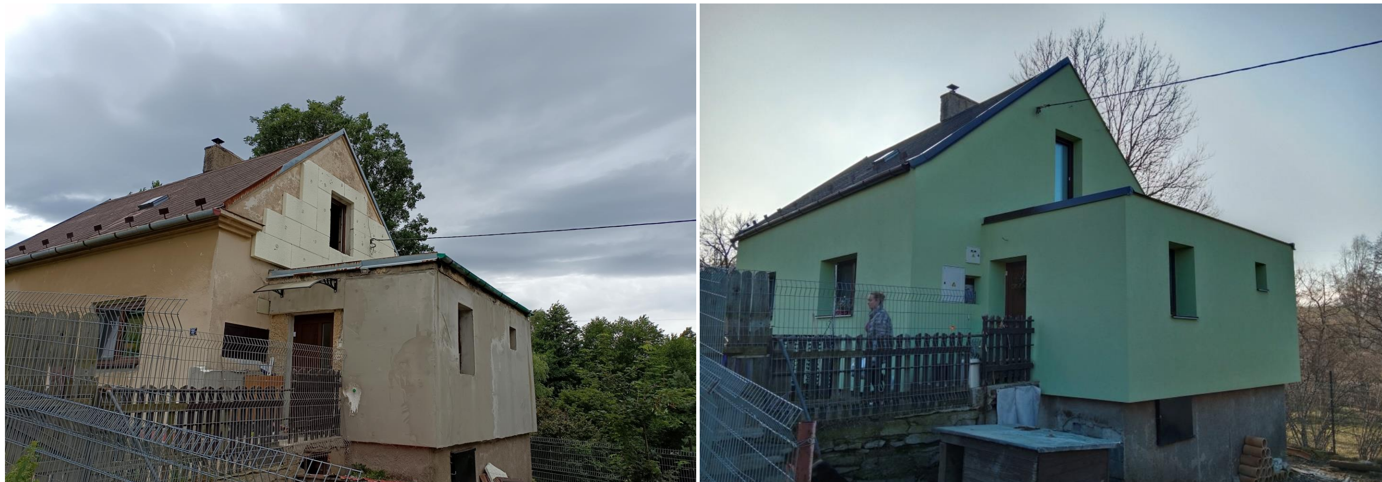
Zateplení fasády a střechy domu v Horním Benešově . Žadatelka samoživitelka se dvěma dětmi – dotace 150 000 Kč.
