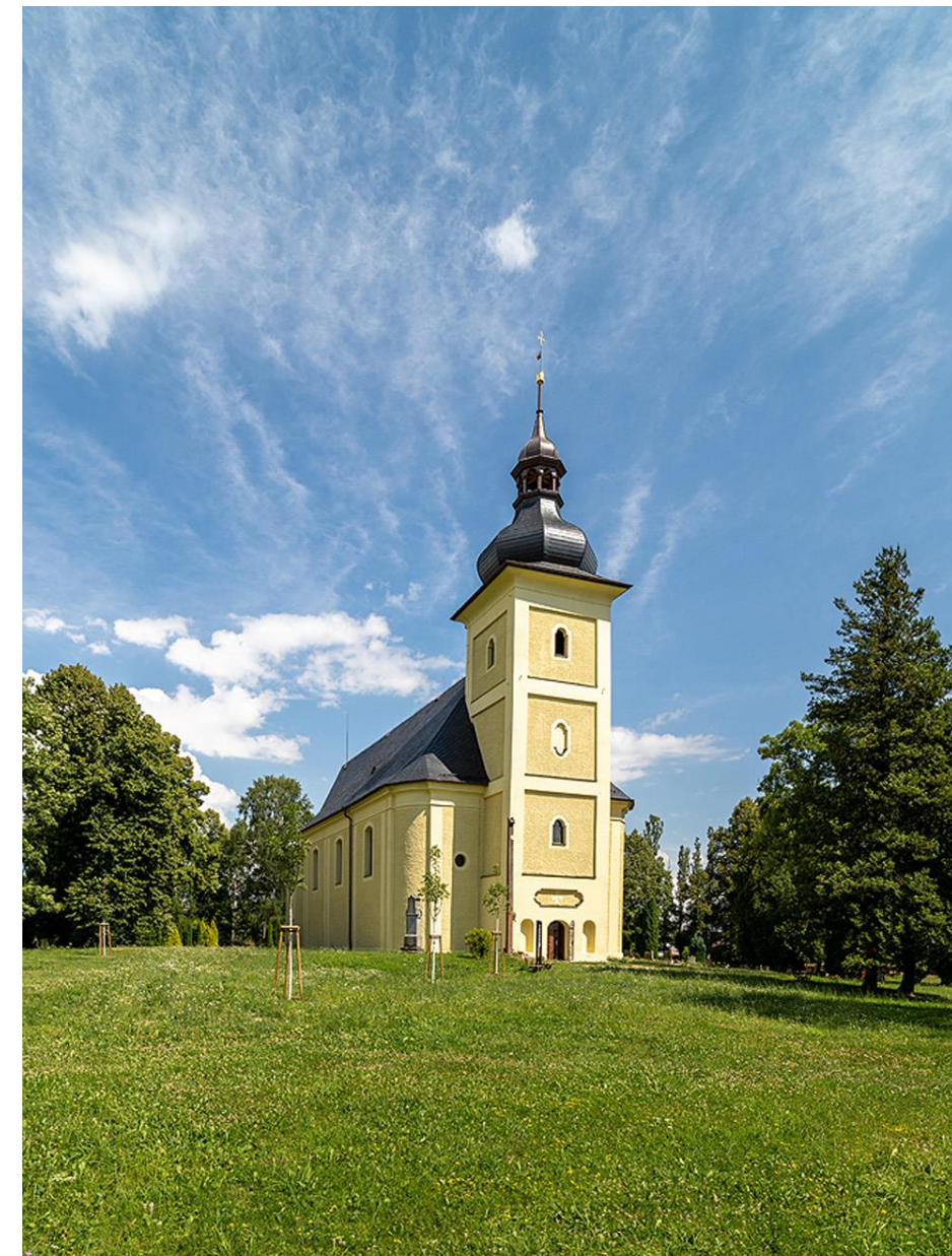
Revitalizace kostela Neposkvrněného Početí Panny Marie ve Starém Městě u Bruntálu MAS Hrubý Jeseník
