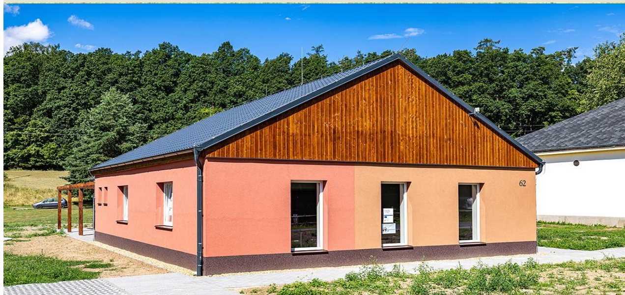
Výstavba zázemí pro poskytování sociálních služeb "Centrum HRAD,, – MAS Rozvoj Krnovska
